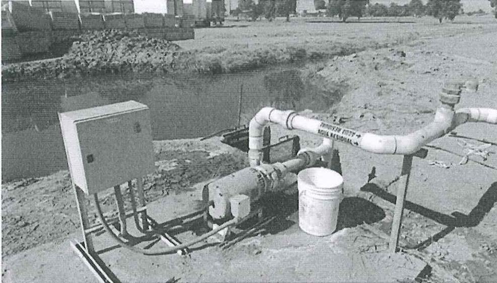
Pozo de aproximadamente 10 metros de diámetro, con una bomba de 10 hp y una línea de descarga que describe agua residual, donde se observa un canal de tierra que conduce el agua hacia una parcela agrícola y un estanque de agua de aproximadamente entre 30 a 40 centímetros de profundidad.
