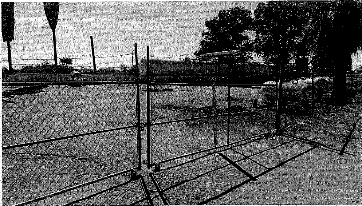
INSTALACIONES DE LA EMPRESA A INSPECCIONAR CERRADAS, CERRADA APROXIMADAMENTE UN AÑO, SEGÚN LA INFORMACIÓN DE LOS LUGAREÑOS.
