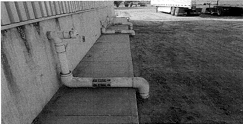
Tubería de 7.62 cm. de diámetro que indica agua residual y otras dos tuberías que describen agua condensada, manifestando la inspeccionada que se conduce hacia un pozo, canal, laguna o predio colindante.
