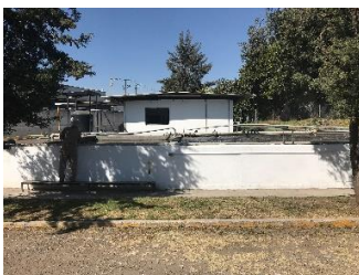
Planta de Tratamiento de Aguas Residuales
