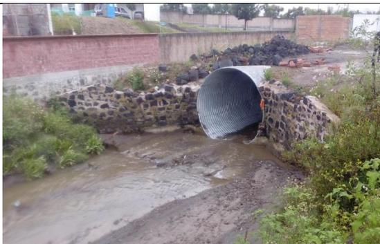
Captación de agua de río, mediante tubo corrugado de acero corrugado de 3.5 metros de Diámetro, cubierto en los márgenes con tierra y material pétreo, ubicado en LN 18°58'58.5" y LO 98°17'07.6"
