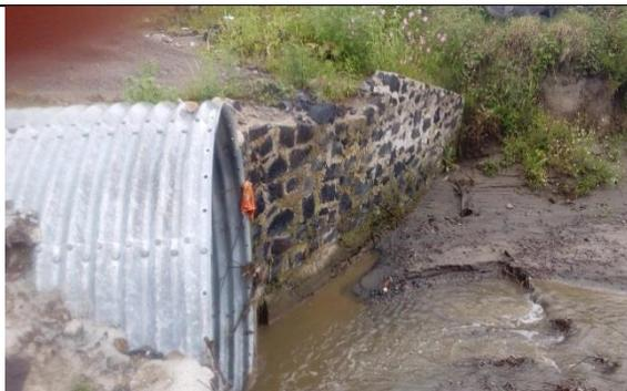
Bardas de contención de piedra y concreto con una longitud de 6.5 metros (lado izquierdo) y 7 metros (lado derecho) con una altura promedio de 2.5 metros.
