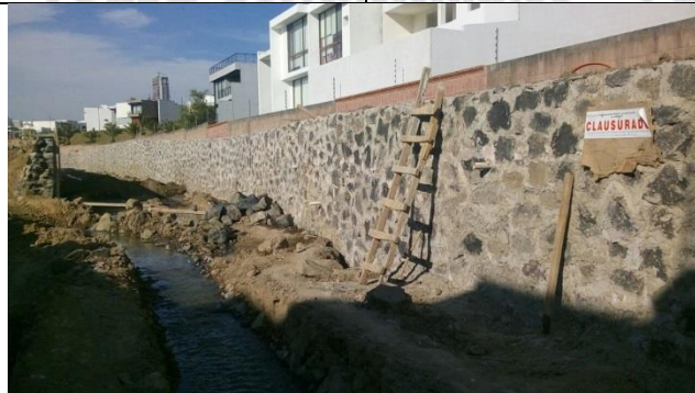
Sello de Clausura sobre muro de contención en
