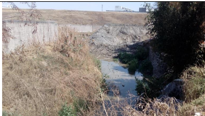
Trabajos de modificación del cauce de la barranca
