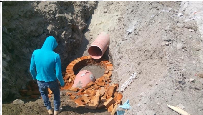
Introducción de tubería para drenaje
