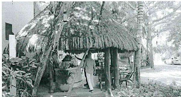
**5.-Área de oficinas**, la cual está construida por estructura de madera dura de la región, piso y paredes de cemento o concreto y techo de zacate, un andador de piedra y losa, la cual **ocupa una superficie total de 140.35 m<sup>2</sup>** (ciento cuarenta punto treinta y cinco metros cuadrados); como se observa en las siguientes fotografías:
