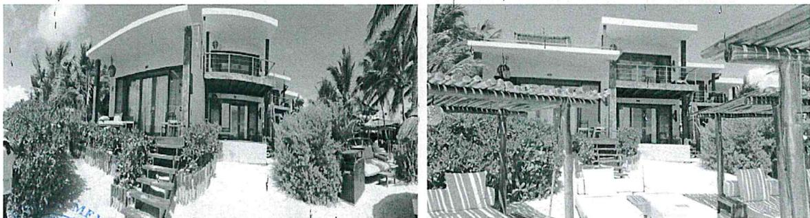
**11.-Una construcción de 2 niveles denominada como "Villa B"**, construida en su totalidad de concreto, escaleras de acceso externas, con acabados de losa de concreto armado, muros de block, mampostería, terrazas las cuales se encuentra construidas por una estructura de madera conformada por pilotes de madera dura de la región, hincados dentro del sustrato arenoso, además cuentan con vigas, largueros y un tendido de tablas o cubierta
