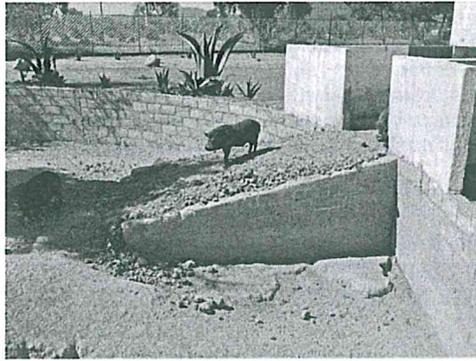
Figura 2.1. Estado actual del encierro, como se observa se construyó la rampa con block para evitar la erosión por pisoteo quedando el acceso al refugio.
