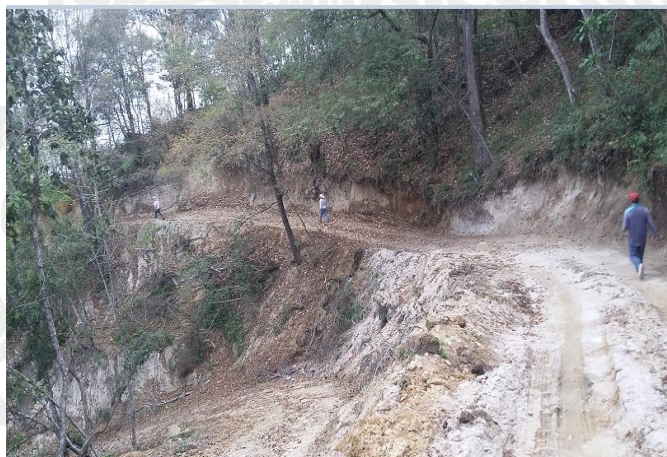
Vista de los cortes de talud, nivelación y compactación por la apertura del camino en el sitio afectado.
