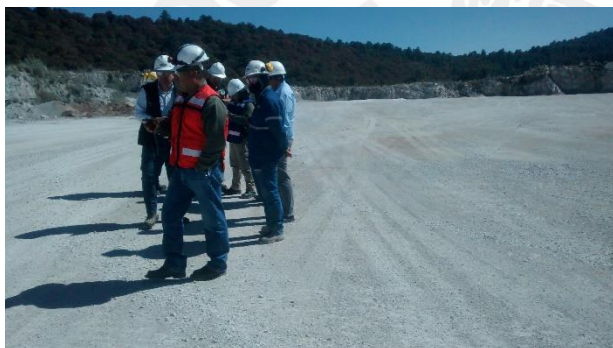
Área del polígono 3, donde se observan terraplén y nivelación.
