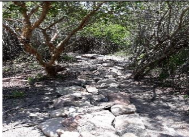
Otro de los enrocamientos sobre el sendero.
