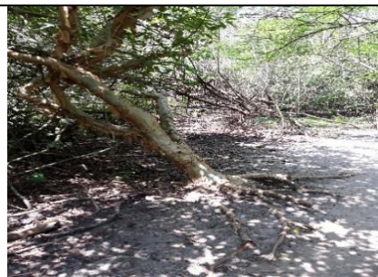
Avistamiento de enraizado de árbol sobre el sendero donde se ve la erosión producto del trasiego de personas al acceso a la playa.
