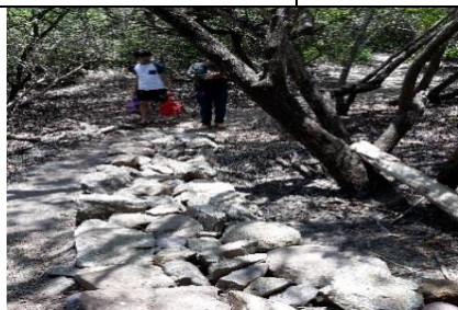
Otro de los enrocamientos sobre el sendero mismo que taponea una vena del estero
