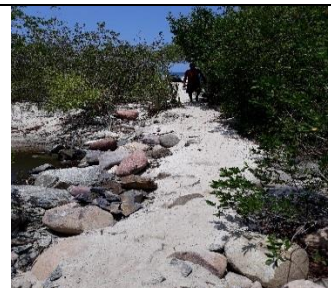
Taponamiento de una vena del estero, utilizado como puente, de roca y arena de mar
