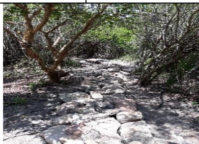
Otro de los enrocamientos sobre el sendero.
