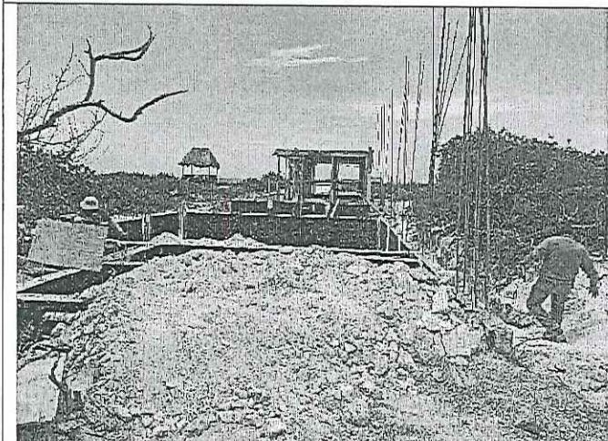
Foto 3. Vista de la obra en proceso de edificación.
