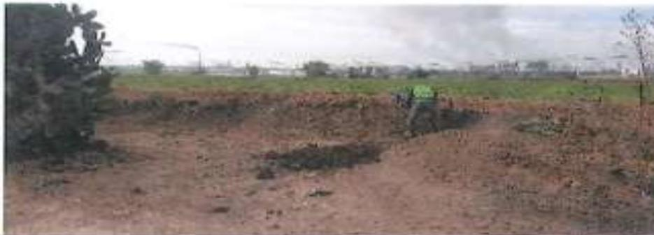
Remoción de tierra impregnada con herramienta manual para evitar contaminación con la retroexcavadora
