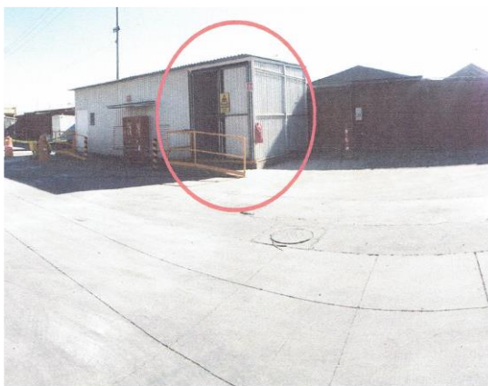
Figura 4. Acceso al almacén de residuos peligrosos sin ningún obstáculo que impida el libre tránsito de equipos mecánicos, eléctricos o manuales así como equipos de emergencias.
