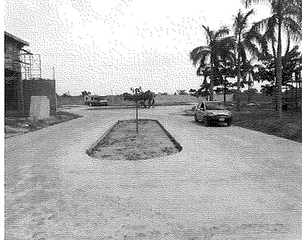
Construcción de infraestructura en privada 1.- Se construyó la calle de concreto, banquetas, guarniciones, así como el sistema de drenaje pluvial, drenaje sanitario, lotificación, barda perimetral, áreas verdes. Se construyó vivienda en un lote el cual se encuentra en obra negra.
