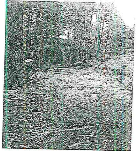
*Vista del sitio donde se realizó la remoción total de la vegetación forestal (desmonte, despalme, nivelación y compactación del terreno para la construcción o apertura de un camino o brecha de saca).*
