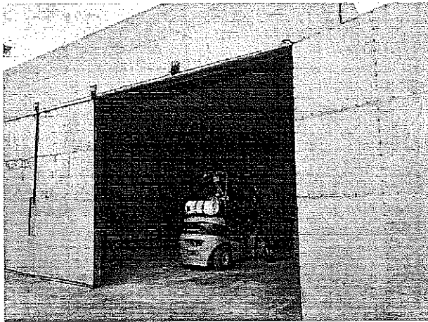
Vista frontal de la cámara para la aplicación del tratamiento térmico fitosanitario
