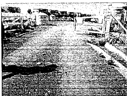
Vista del camino de acceso
