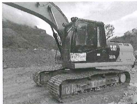
Vista de la maquinaria "Asegurada"
