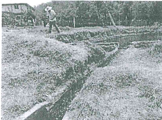
Vista del desarenador
