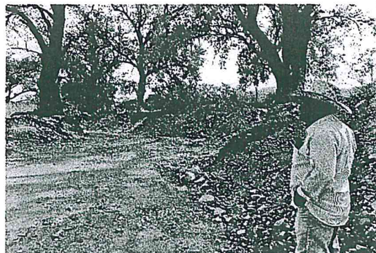
Vista de la acumulación de material en el cauce del río
