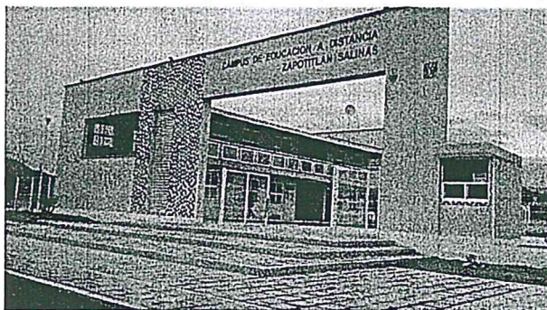
Frente de la obra la cual colinda con la carretera federal Tehuacán – Huajuapán de León
