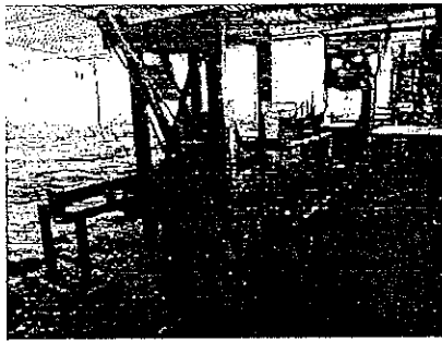
Vista de la maquinaria fuera de operación
