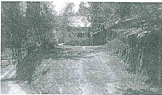
Apertura de camino principal
