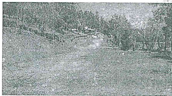
Vista del lugar inspeccionado
