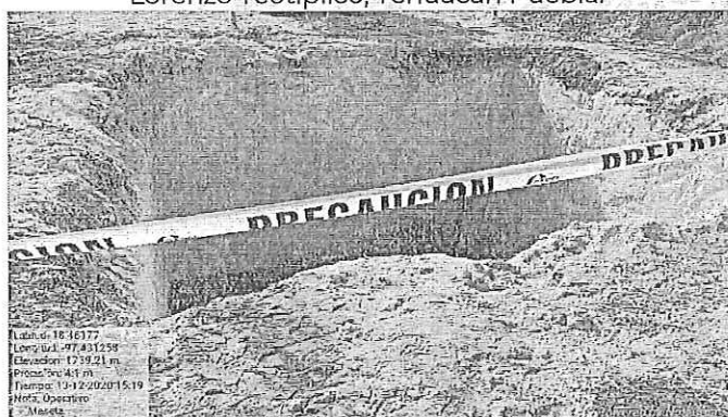
Apertura de zanja para establecimiento de antena de telefono.
