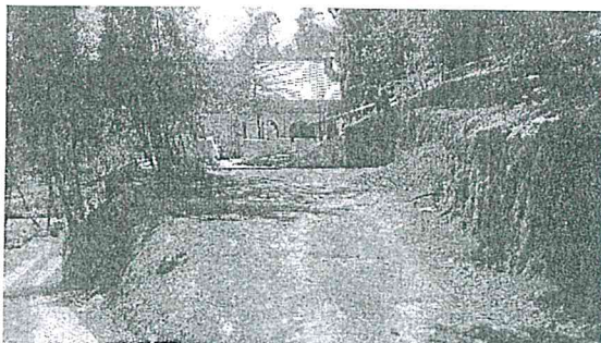
Apertura de camino principal
