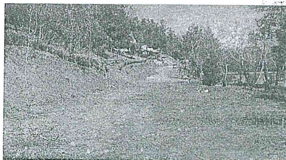
Vista del lugar inspeccionado
