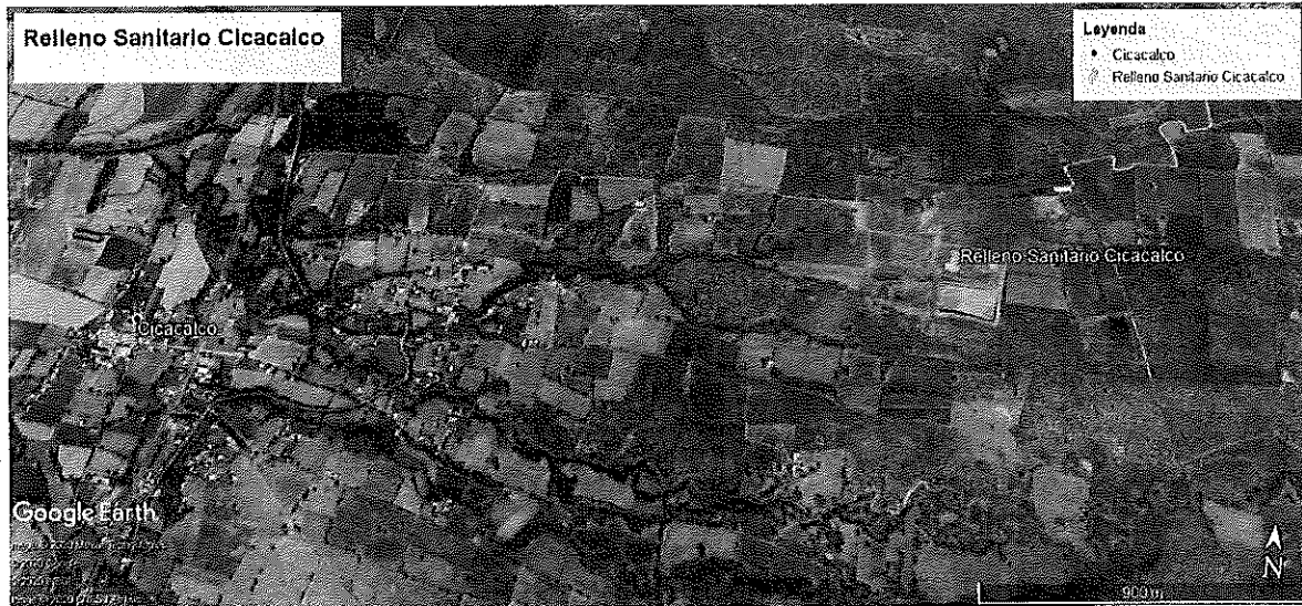
Relleno Sanitario Cicacalco, municipio de Tlaltenango de Sánchez Román, Zac
